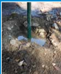
Megkötött anyag utónedvesítése
