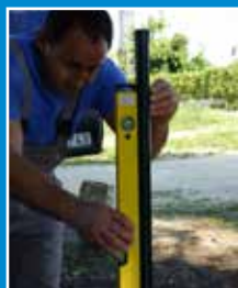
Oszlop függőbe állítás
