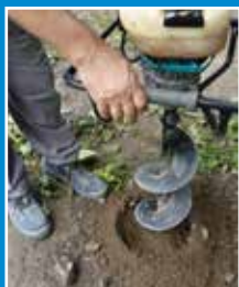
Alapgödör kialakítása
